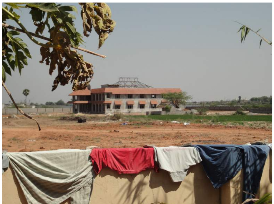
Das neue Gebäude im Rohbau
